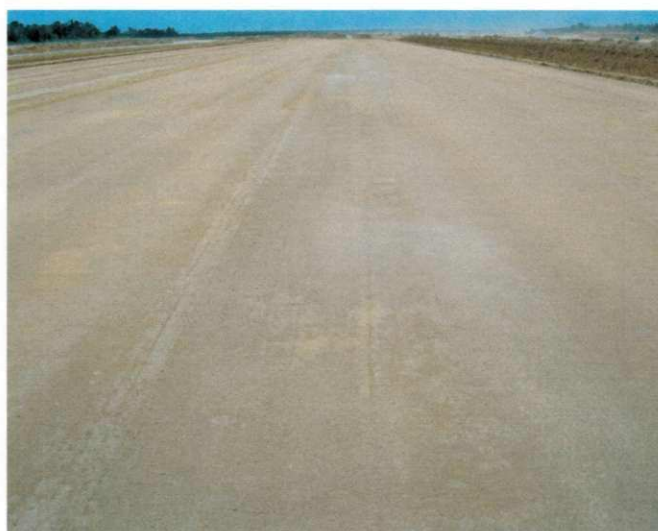
Figura 4.13 – Trecho de sub-base executada com a mistura de solo mais pó-de-pedra [Complexo Aeroportuário da Grande Natal – RN]
