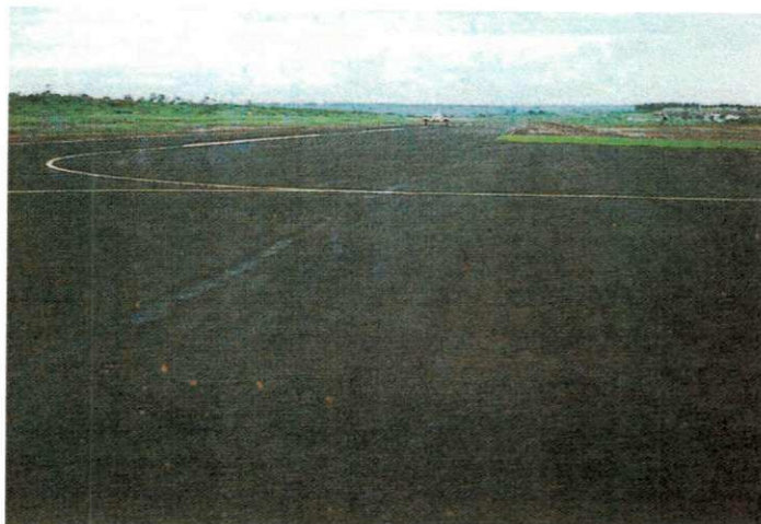
Figura 2.4 – Pista de aeródromo com base SAFL (NOGAMI E VILLIBOR, 1995)
