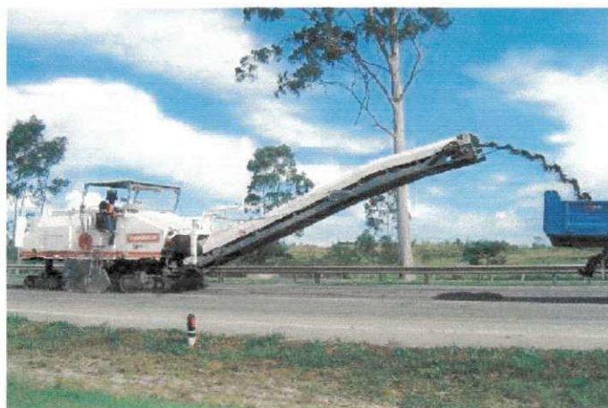
Figura 2.5 – Fresagem “in situ” de camada asfáltica [Fonte: www.fresar.com.br ]
