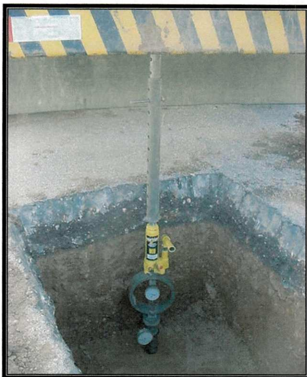
Figura 3.12 – Realização do ensaio de CBR “in situ”.
