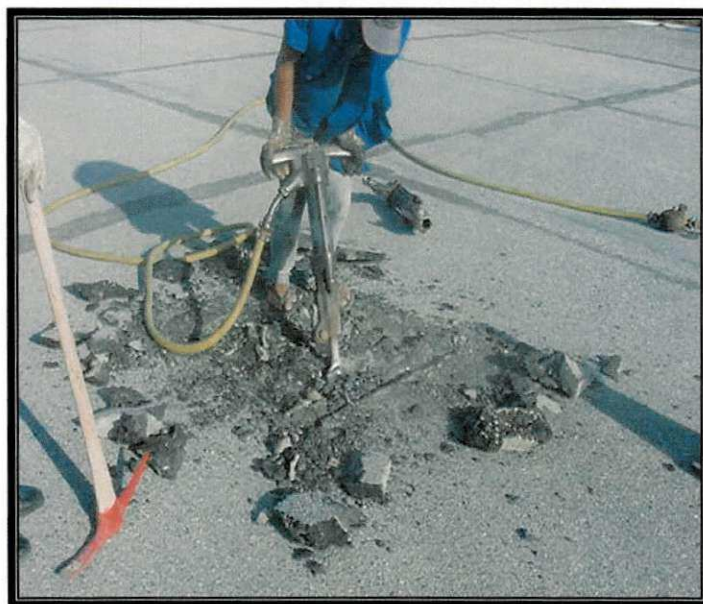
Figura 3.2 – Abertura dos poços de inspeção (PI - 101) - retirada do revestimento em CBUQ.
