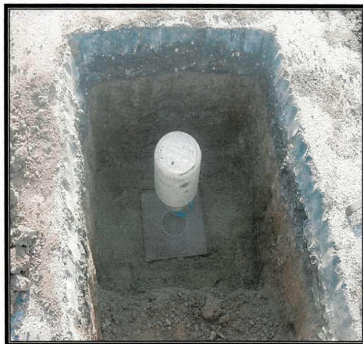
Figura 3.4 – Poço de inspeção (PI - 201) - realização dos ensaios “in situ”.
