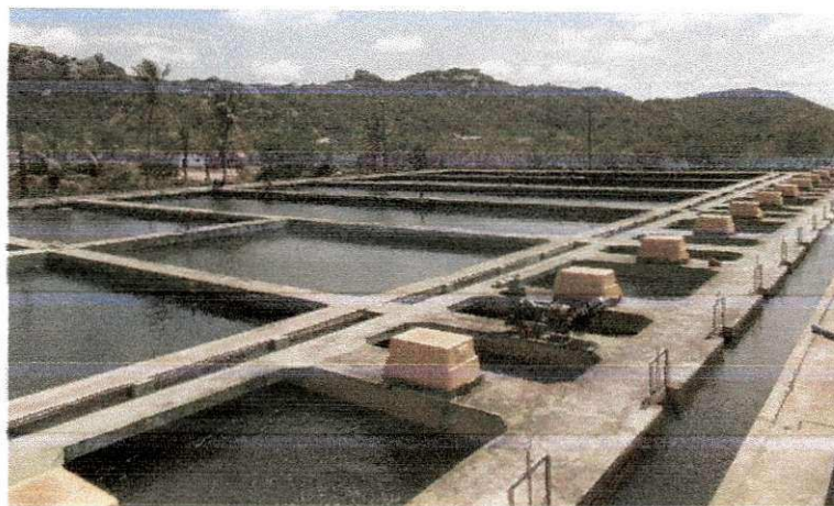
Figura 4.4- Unidades de tratamento da ETA Gravatá.
