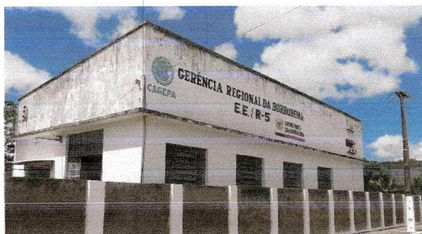
Figura 4.8-Detalhe da entrada do reservatório R-5
