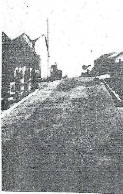
Construção do calçamento até a praça Sebastião Bandeira de Melo
