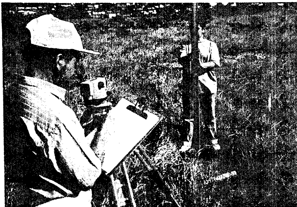
Figura 3.37. Execução de Leituras de Nivelamento
