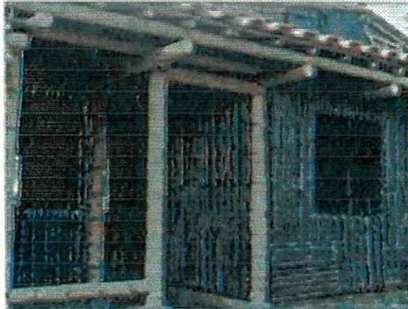
Figura 74: Colocação da malha metálica
