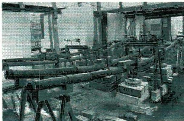
Figura 66: Ensaio de flexão em colmos inteiros de bambu
