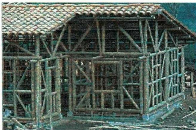
Figura 72: Armação de bambu:
