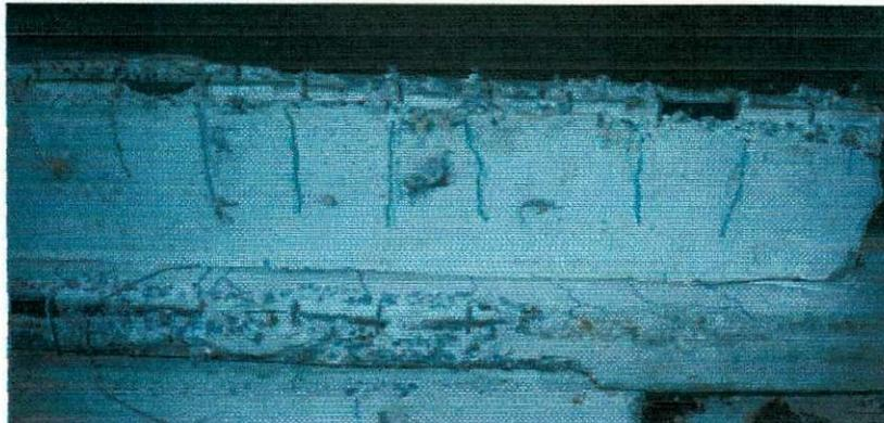
Figura 98: Detalhe da fissuração provocada pelos pinos
