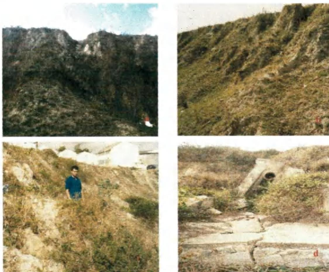
Figura 13. Processos erosivos ativos (sulcos e voçorocas) comprometendo a infra-estrutura ao longo de todo o açude
