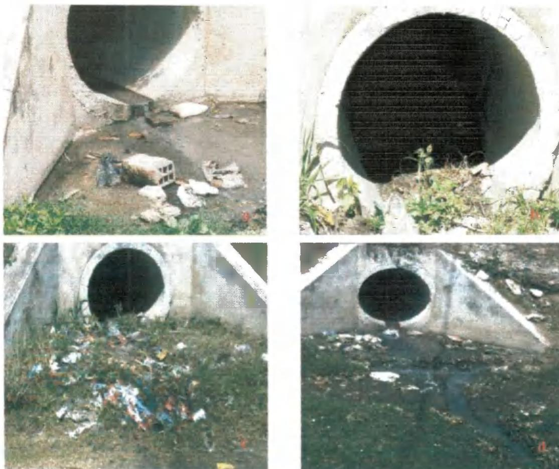
Figura 17. Galerias pluviais com escoamento de esgoto e resíduos sólidos de diversas origens (industrial e doméstico) em vários pontos, ao longo do açude
