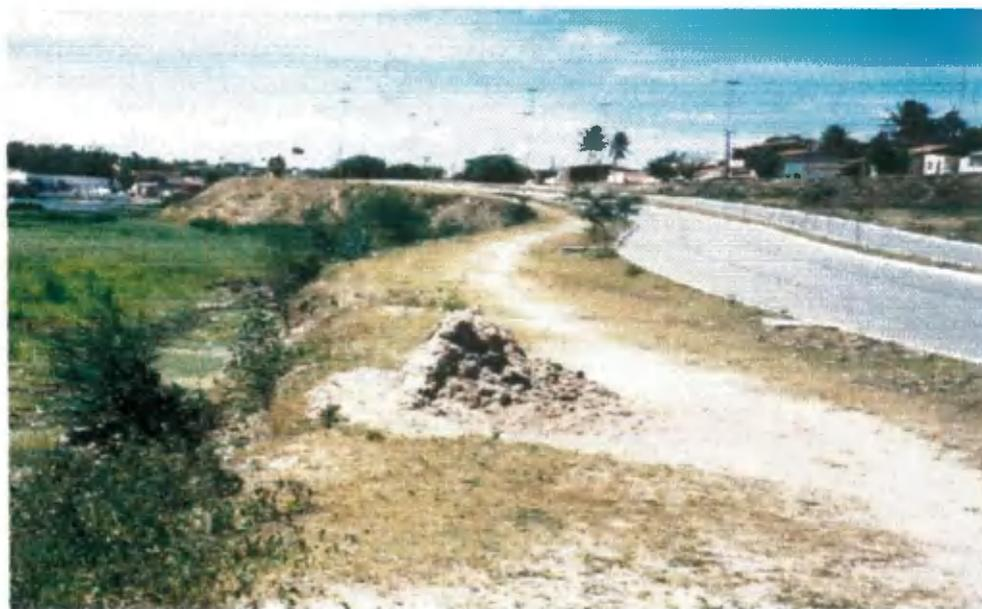
Figura 14. Extração mineral (areia) praticada na barragem de contenção do açude
