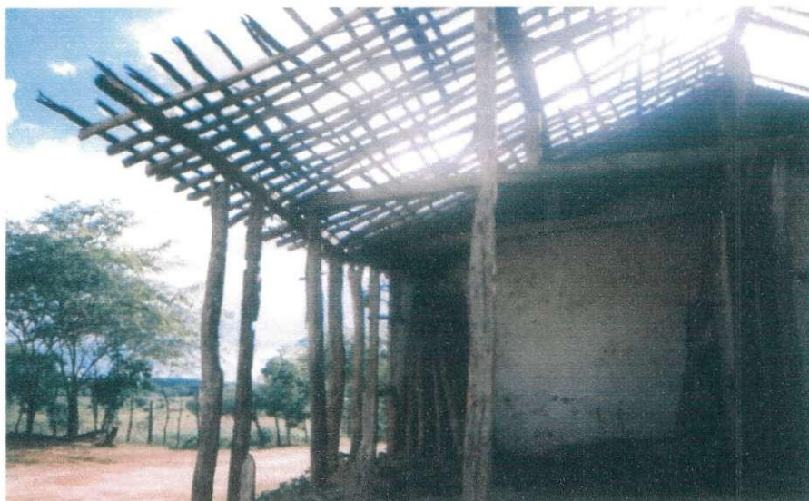
Figura 8- Estruturas de sustentação e cobertura feitas com madeiras de angico, aroeira, louro-pardo, pau d'arco e marmeleiro, de Classes Diâmetricas variadas, na antiga sede da Fazenda Pinheiros, construída no ano de 1924 (Camalaú - PB).
