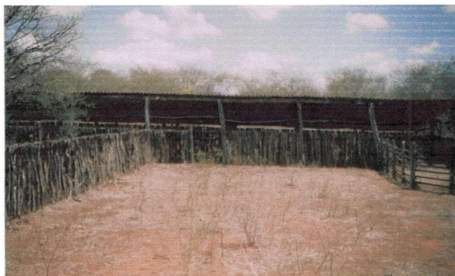
Figura 6 - Vista parcial de aprisco construído com madeiras de jurema-preta e angico, Fazenda Resende (São José de Espinharas - PB).
