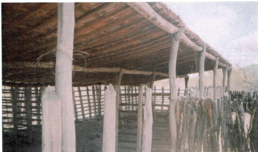
Figura 7 - Detalhes do aprisco mostrado na Figura 6. Os moirões, colunas e vigas de angico de Classes Diamétricas III e IV, e estacas de jurema-preta de Classes Diamétricas I e II.
