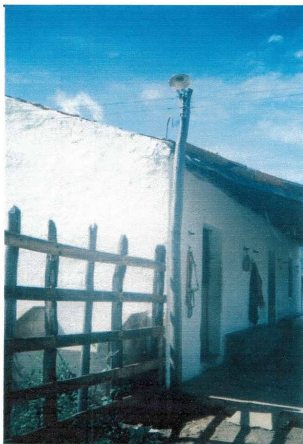
Figura 11 - Poste de madeira de angico com Classe Diamétrica III, Fazenda Ipueiras, (Várzea - PB)
