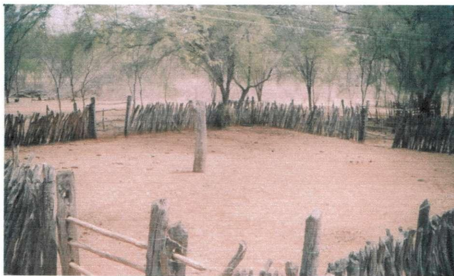
Figura 4 - Curral confeccionado com estacas de jurema preta de Classes diamétricas I e II, reforçado com moirões de angico de Classe Diamétrica III, Fazenda Resende (São José de Espinharas - PB)
