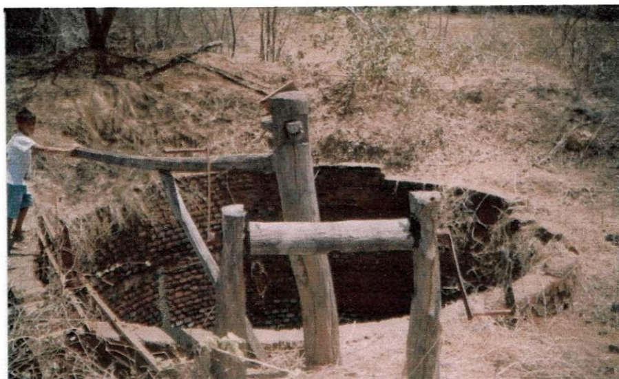
Figura 9 - Guindaste para limpeza de poço amazonas construído com madeira de angico de Classe Diamétrica III e IV, Fazenda Mucunã (São José de Espinharas - PB).
