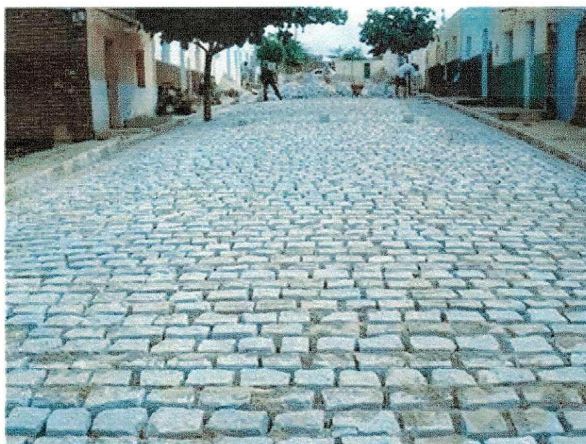
Figura 2.4 – Execução do pavimento semi-rígido.
