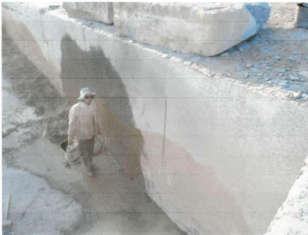
Foto 05 - Cortes vertical e horizontal a fio diamantado.
