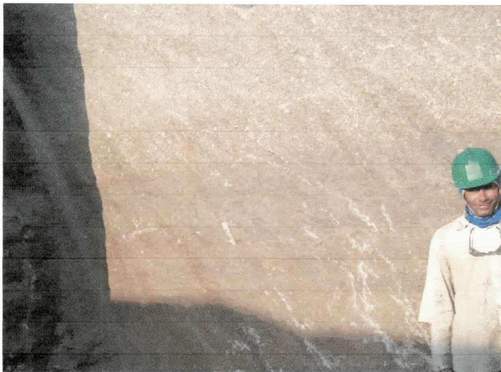
Foto 03 - Bancada cortada a fogo – Jat Flame .
