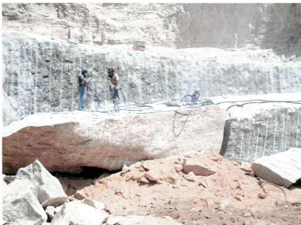
Foto 17 - Prancha na posição horizontal e furação para confecção de blocos.
