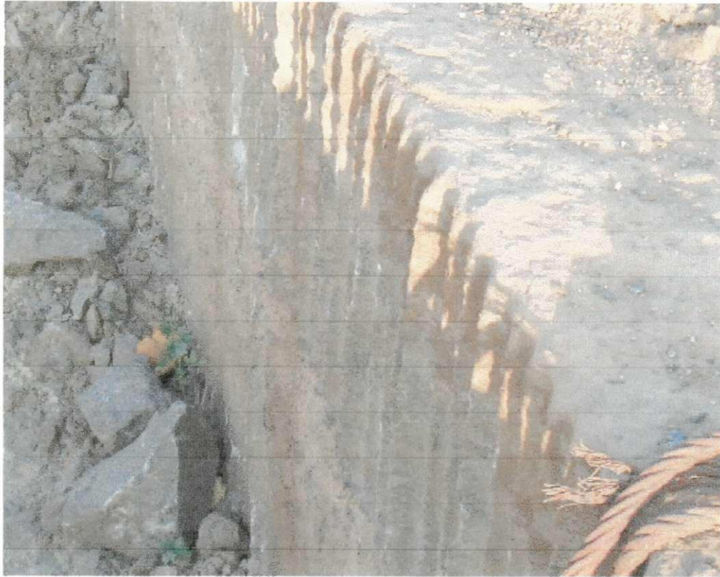
Foto 01 - Bancada cortada com perfuração contínua (vista superior).
