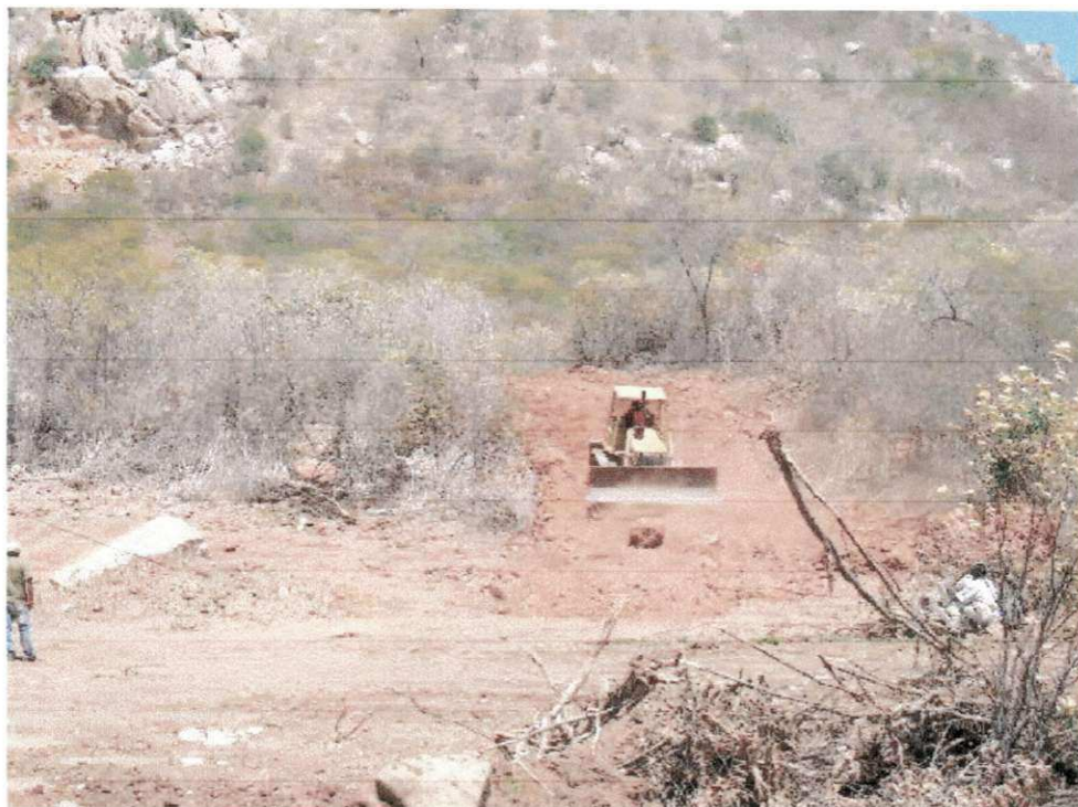
Foto 23 - Acesso ao corpo (canto esquerdo superior).
