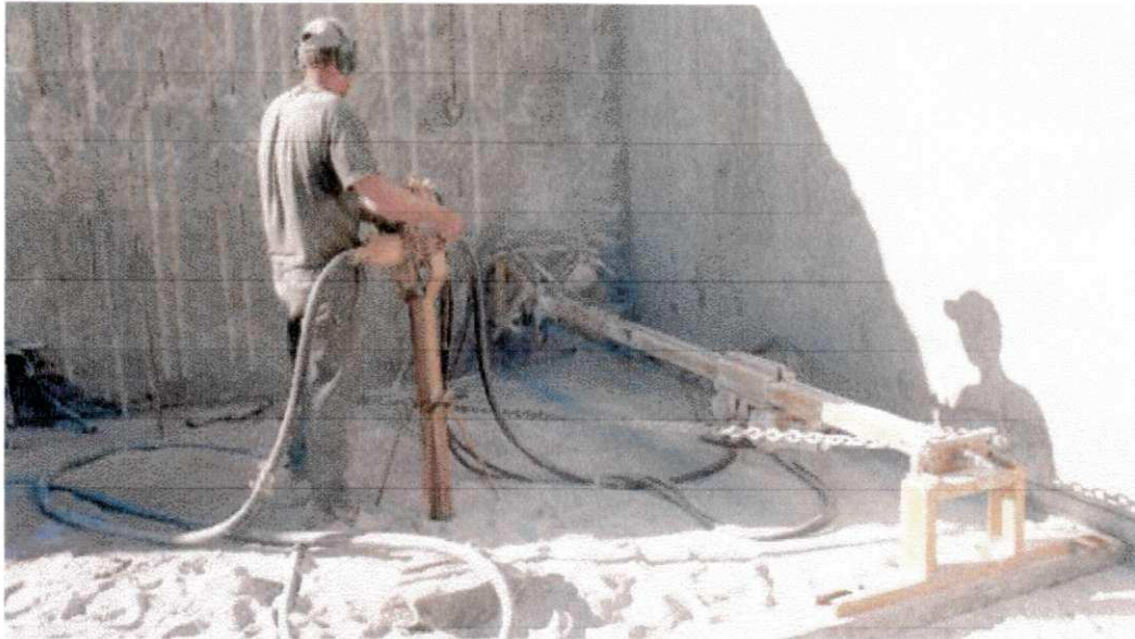
Foto 04 – Perfuratriz “fundo furo”, instalada para executar um furo horizontal.
