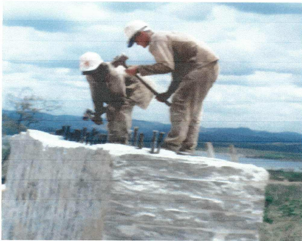
Foto 27 – Trabalho de acunhamento.
