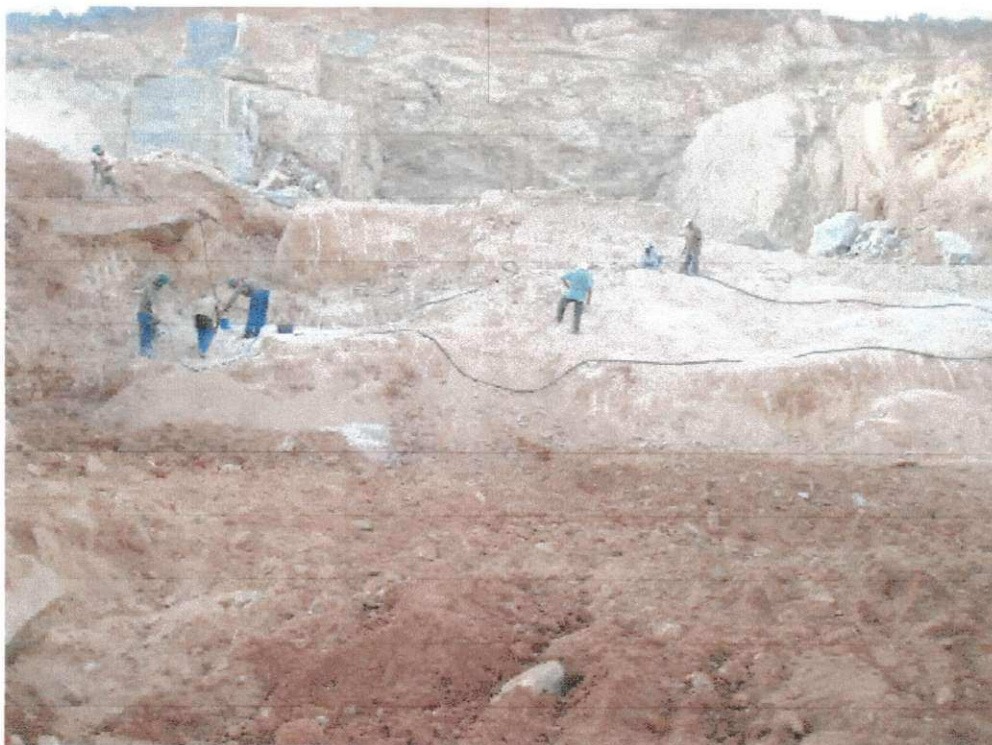
Foto 14 - Furação de rocha alterada para o desmonte e posterior limpeza.
