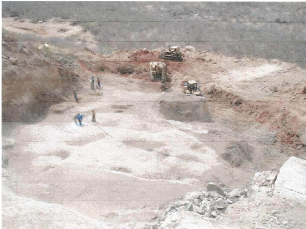
Foto 15 - Rocha decapeada, com alguns desmontes de limpeza a serem executados.
