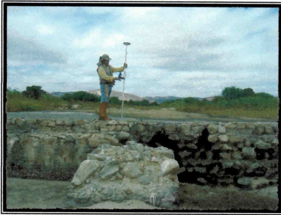
Figura 4.7 - Barragem de Pedra e Cal
