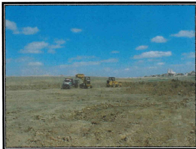
Figura 4.1 - Máquinas trabalhando no leito do Açude Público de Santa Luzia
