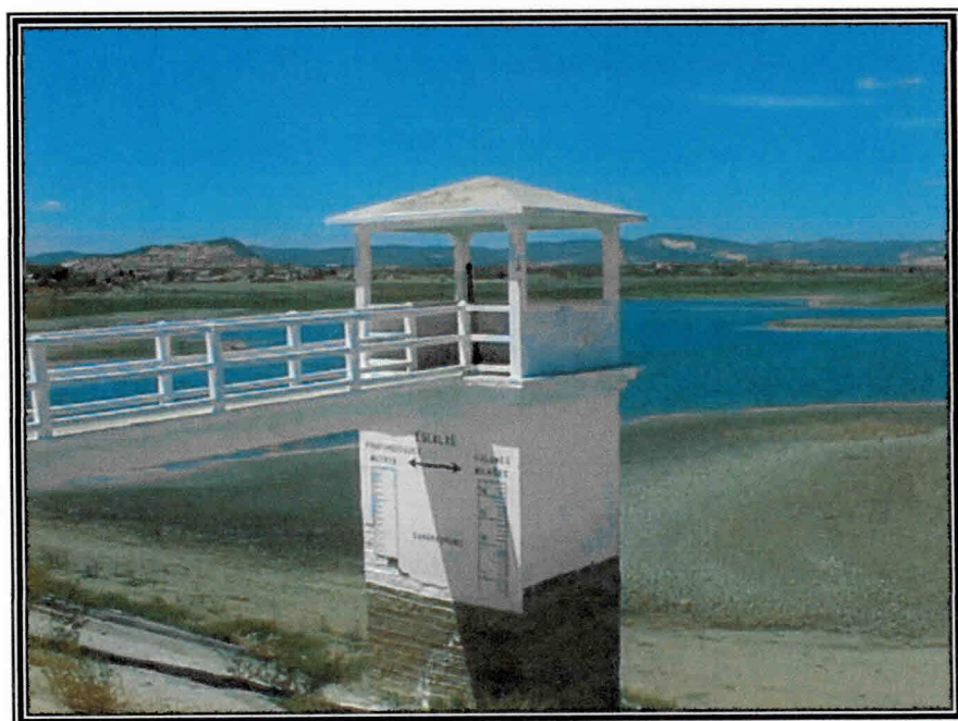
Figura 3.6 – Comporta graduada – Açude de Santa Luzia Fonte: Araújo, Beranger A.
