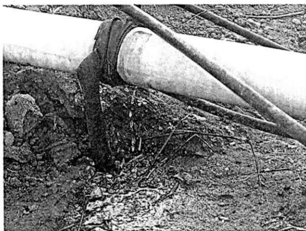
Foto 4.2. Linha de gotejador furada, amarrada com borracha
