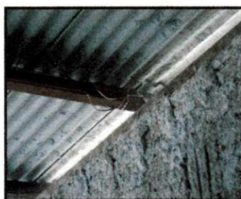
Figura 2. Telha de amianto
