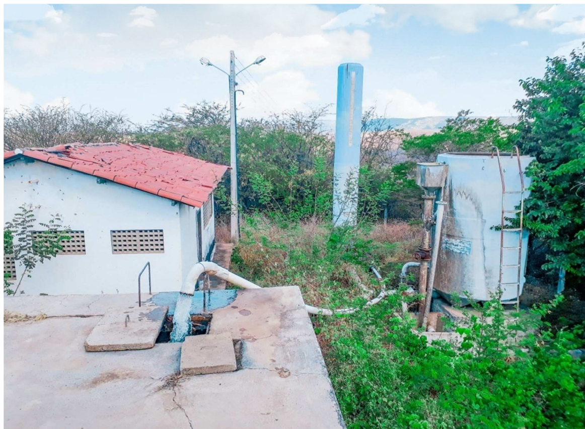
Foto 14: Adutora do açude prazeres.
