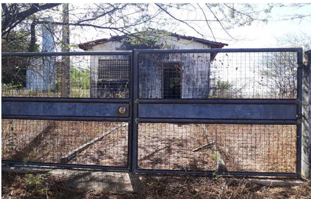
Foto 13: Adutora do açude prazeres.
