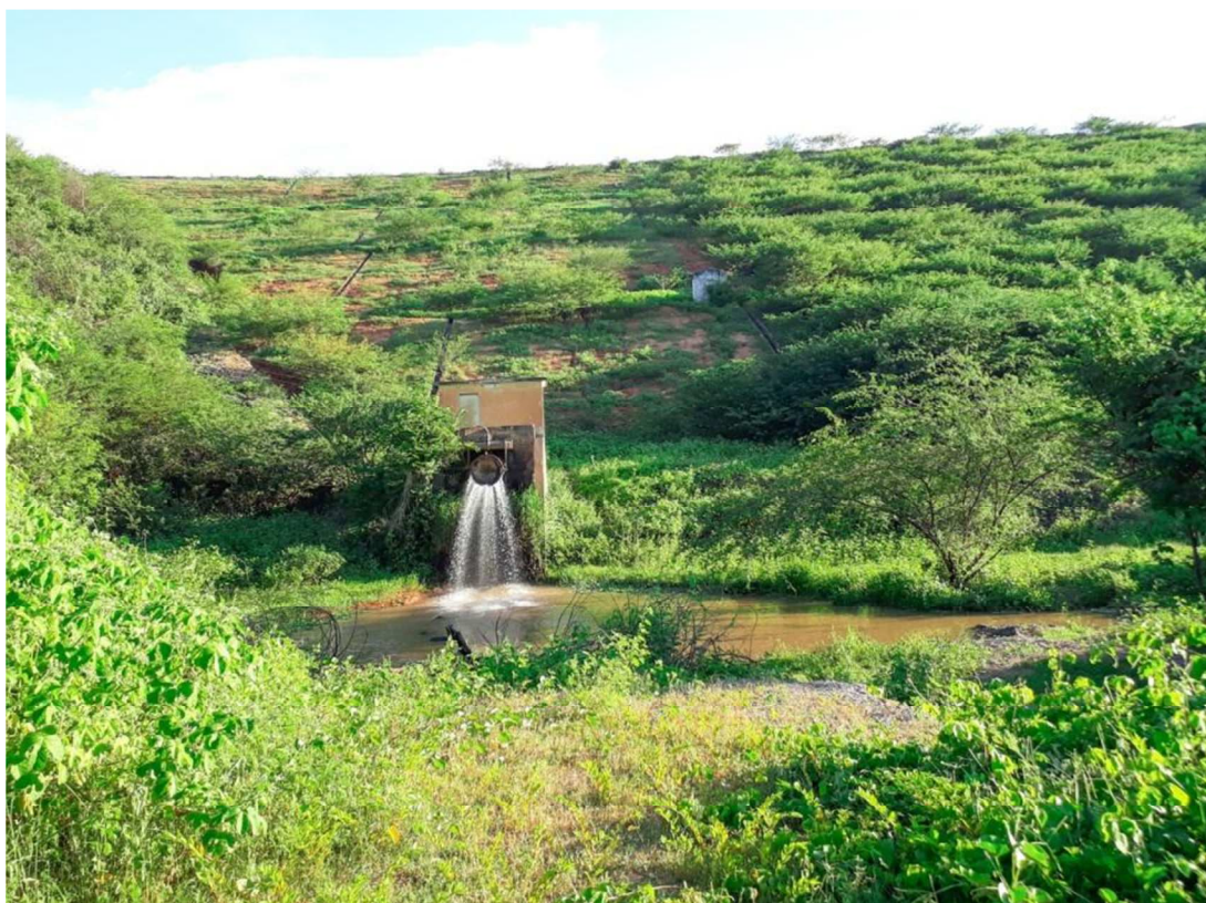
Foto 04: Comporta Hidráulica do Açude Prazeres.
