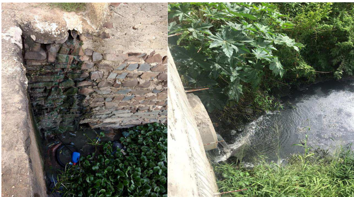
Figura 05. Esgoto doméstico sendo lançado diretamente no rio.
