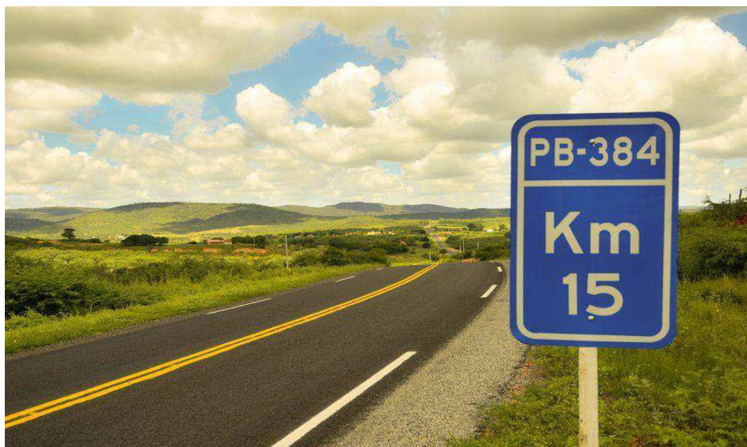
Imagem 6 – Pavimentação da PB-384 concluída
