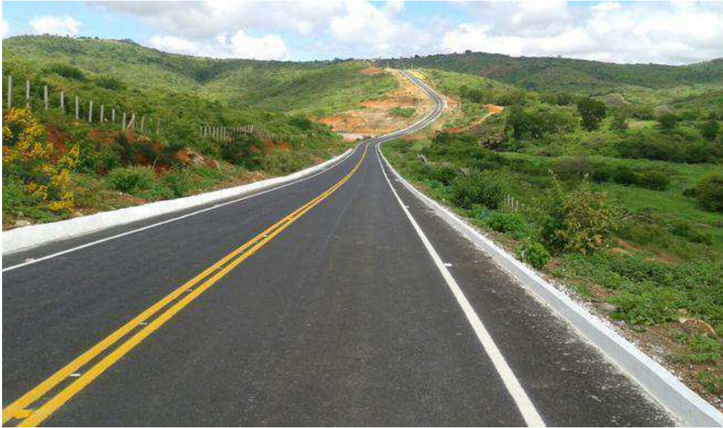
Imagem 3 – Pavimentação concluída em Bernardino Batista
