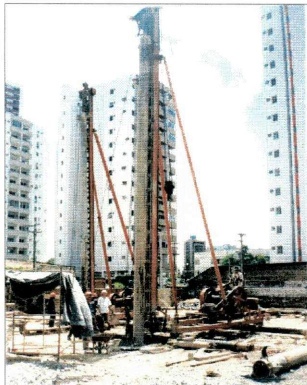
**Figura 3.4 – Equipamento de execução das estacas de compactação.**
