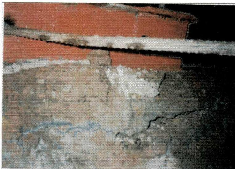
**Figura 3.7 – Rompimento da ancoragem.**
