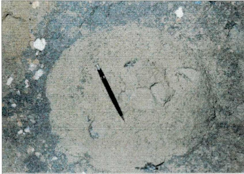
**Figura 3.18 – Esmagamento da cabeça da estaca de compactação.**
