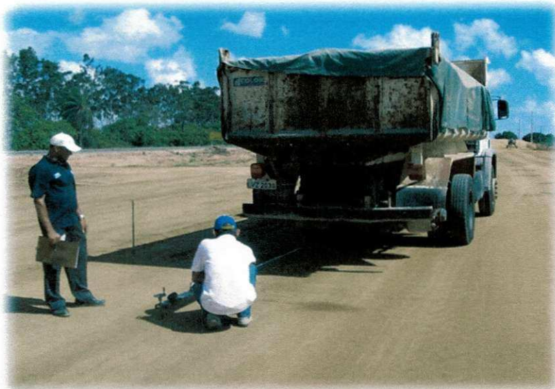
Figura 3.8 – Medidas de Deflexão com a “ viga Benkelman ” na camada de terraplanagem.
