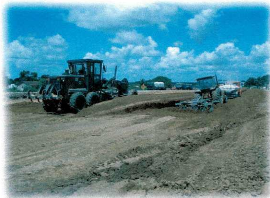
Figura 3.4 – Execução dos serviços de terraplenagem.
