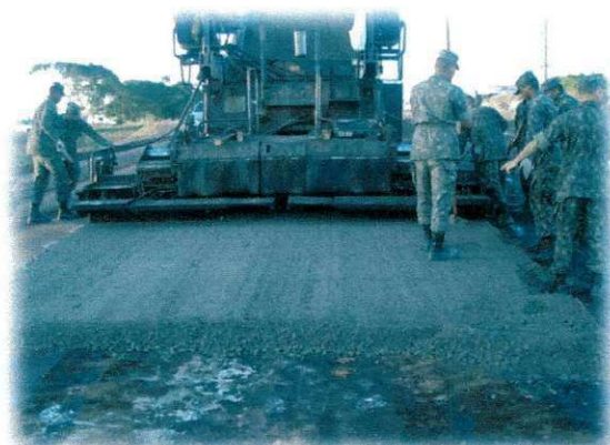
Figura 3.5 – Execução da Camada de CCR.
