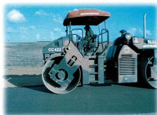
Figura 3.5 – Execução da Camada de CCR.
