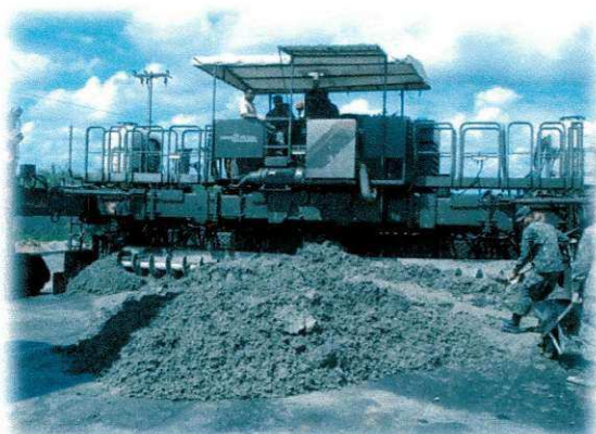
Figura 3.6 – Execução da Placa de concreto em cimento Portland.
