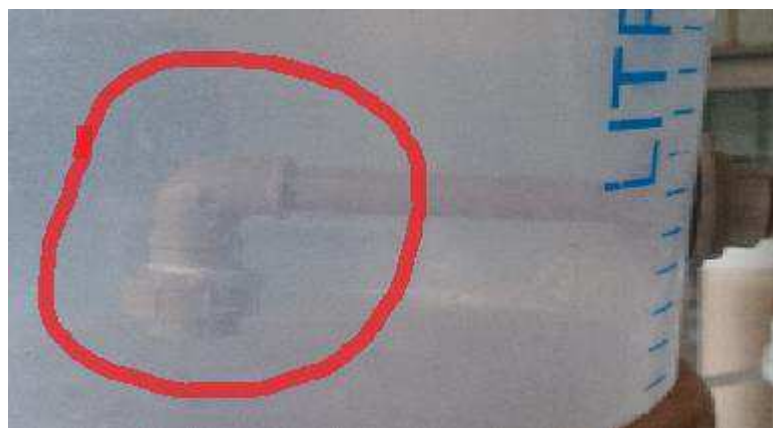
Figura 19 – Detalhe da caixa de distribuição.
