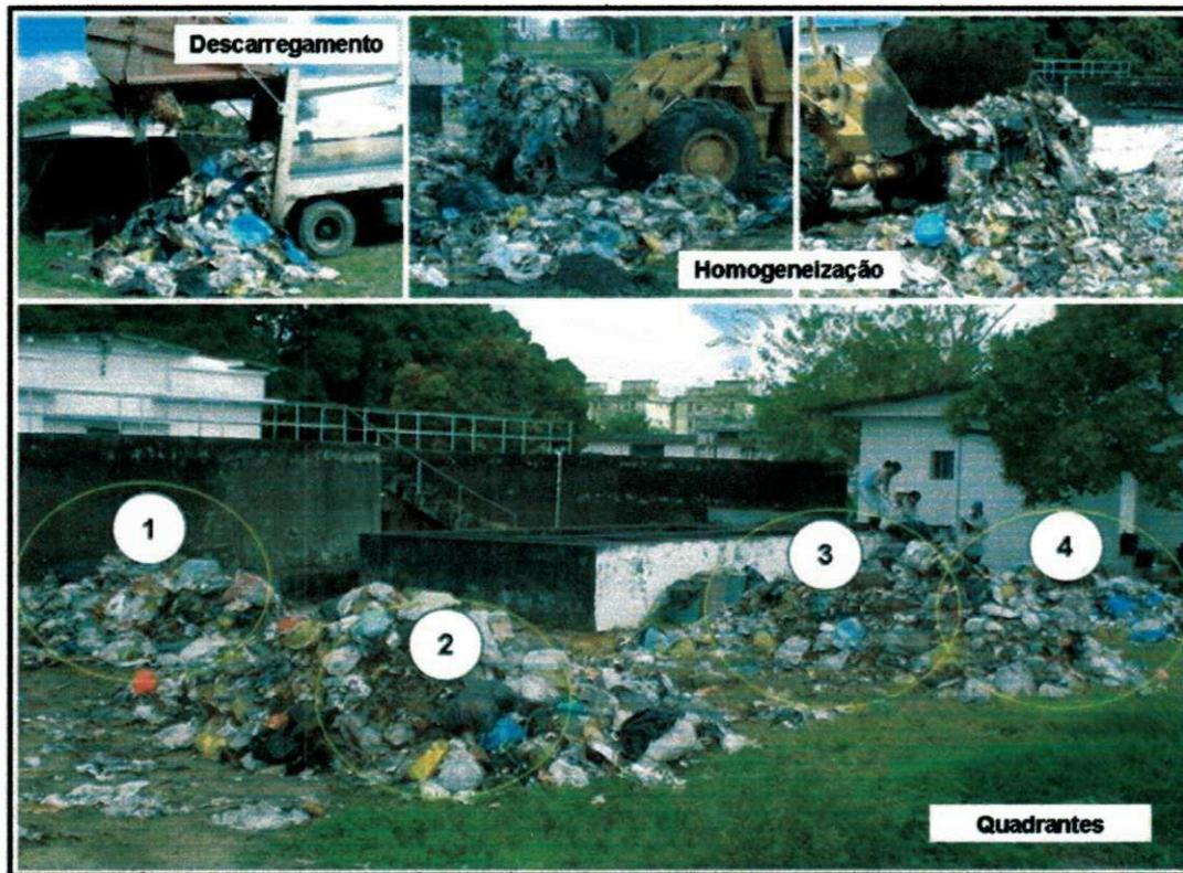
Figura 16. Descarregamento, homogeneização do material e divisão das pilhas
