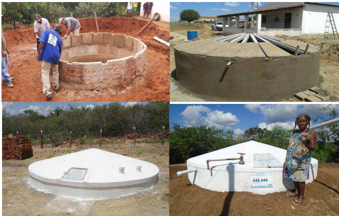
Figura 2. Estrutura básica na construção de cisternas
