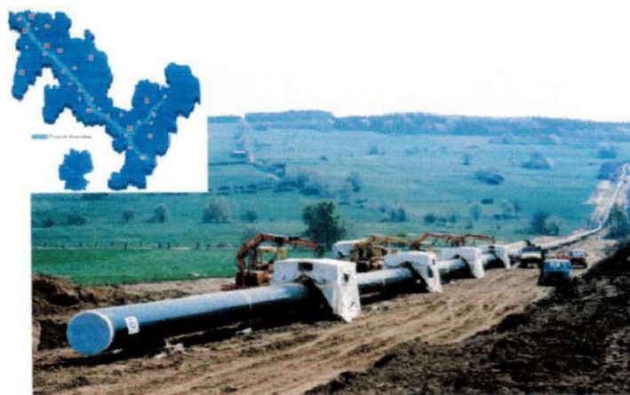
Figura 3.3 – Primeira Linha de tubulações utilizando X80 na Alemanha (KALWA et al., 2002).
