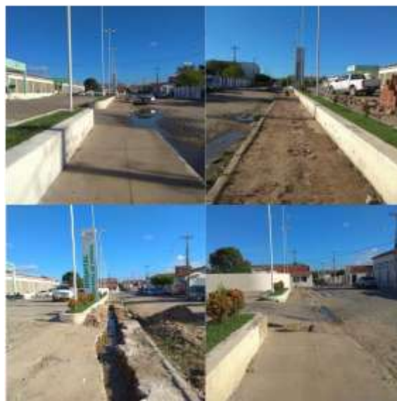
Figura 3 - Fotografia "Calçada em reforma"
