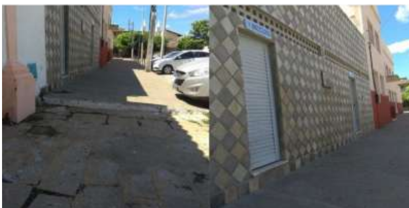
Figura 7 - Fotografia "Banheiros Públicos"
