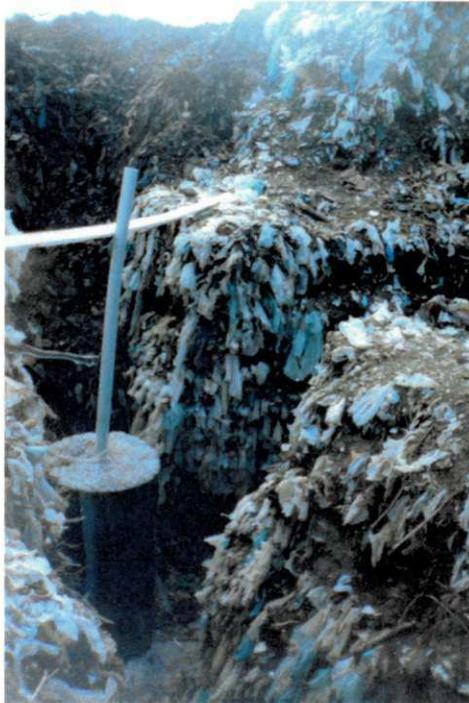
**Figura 4.26 - Colocação dos drenos de gases na célula 01 do lixão do Roger.**
