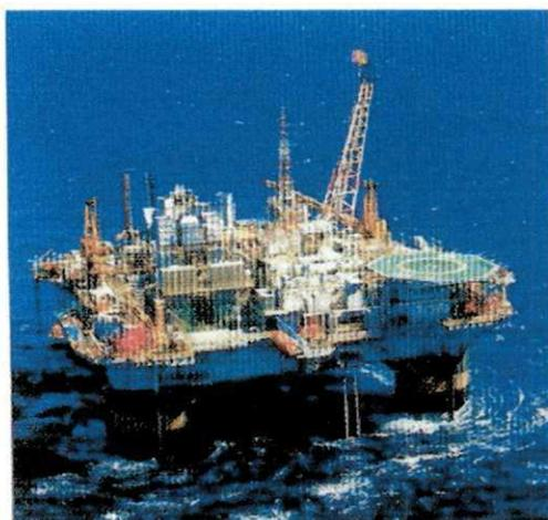
Figura 1.8 – Plataforma semi-submersível da Bacia de Campos – RJ (Mini-Site PETROBRAS, 2000)
