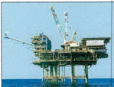
Figura 1.3 – Plataforma fixa de perfuração e produção (Triggia, 2001).
