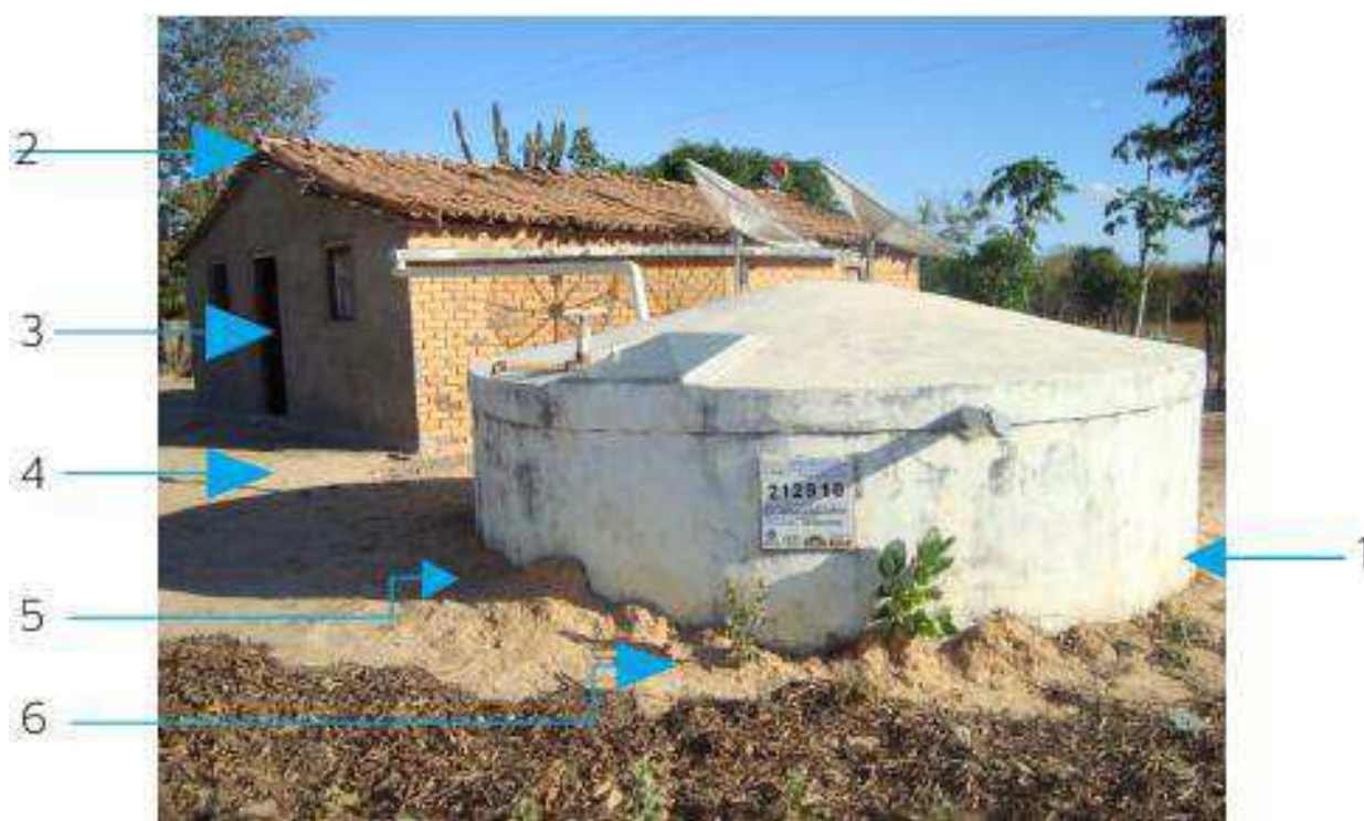
Figura 1: Cisterna de Placa construída pelo Programa Um Milhão de Cisterna (P1MC)
