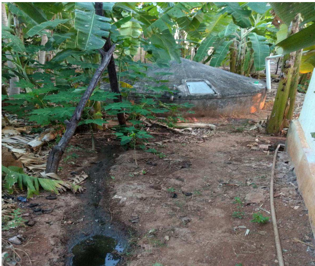
Figura 2: Característica de ambiente inadequado para localização da cisterna de placa
