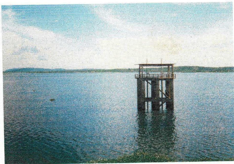
Fotografia C.3.1 –Bacia hidráulica do reservatório Coremas
