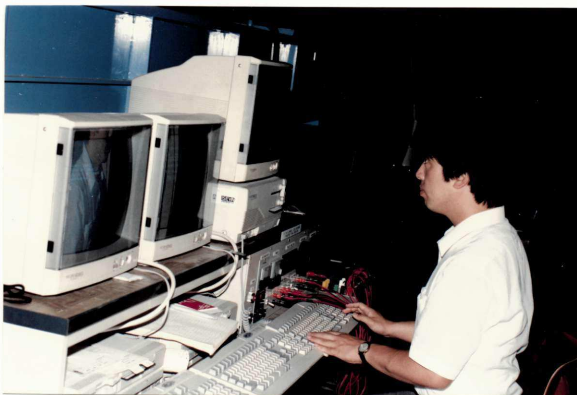
Foto 4.4 Vista do sistema de controle.
