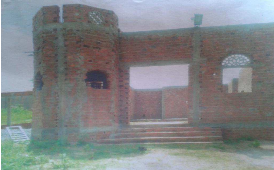
Foto 13: Construção da Igreja Católica da comunidade
