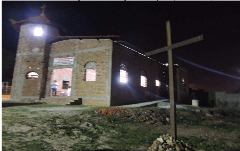
Foto 15: Avanço na construção da Capela (22/01/2017)
