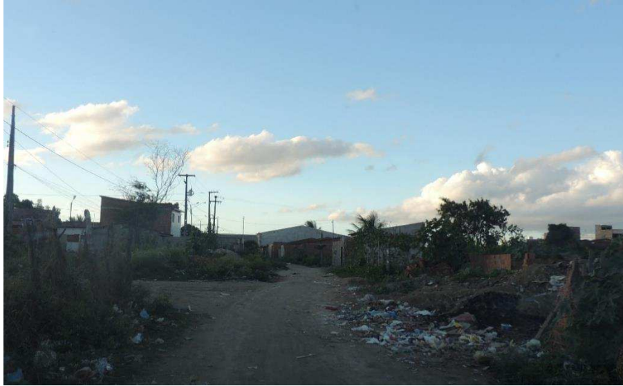
Foto 18: Lixo e ruas sem calçamento como algumas das consequências da falta de urbanização da comunidade
