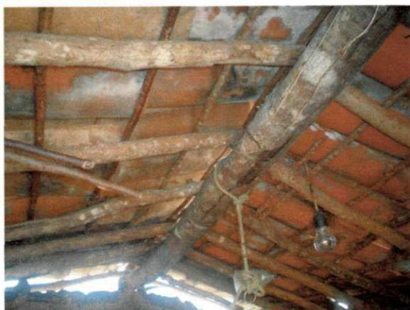
Figura 10- Lâmpada incandescente sem nenhum tipo de proteção
