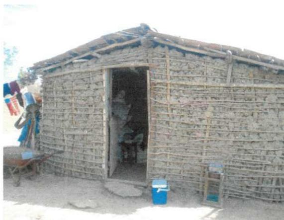
Figura 13 – Instalação com paredes de barro (taipa ou pau-a-pique) piso em chão batido
