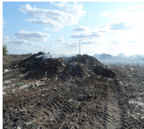
(F) Limpeza da área do lixão
