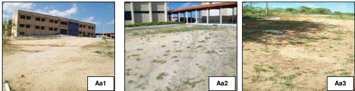
Figura 19 - Focos de erosão laminar na Área antropizada do Campus da UFCG em Pombal - PB
