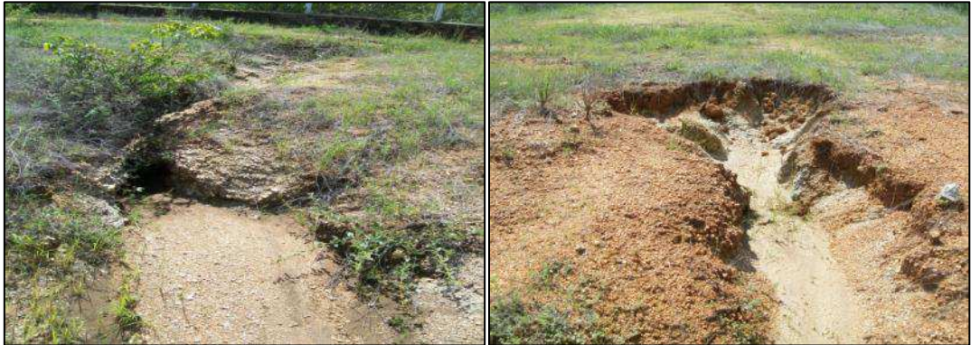
Figura 21 - Focos de erosão do tipo voçoroca em áreas do Campus da UFCG em Pombal – PB
