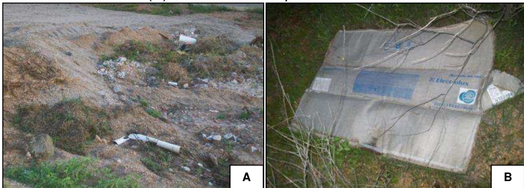
Figura 15 - Descarte inadequado de resíduos de construção civil (A) e outros resíduos sólidos (B) na área do Campus da UFCG em Pombal - PB
