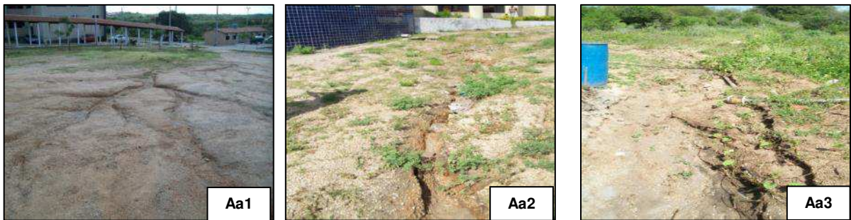
Figura 20 - Focos de erosão em sulcos na Área antropizada do Campus da UFCG em Pombal - PB
