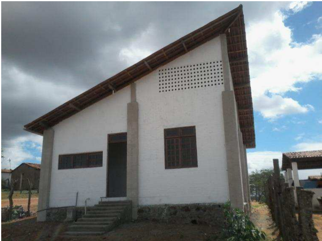
Figura 15 - Fotografia da vista posterior da Residência
