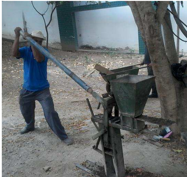
Figura 11 – Confeção dos tijolos de solo-cimento.
