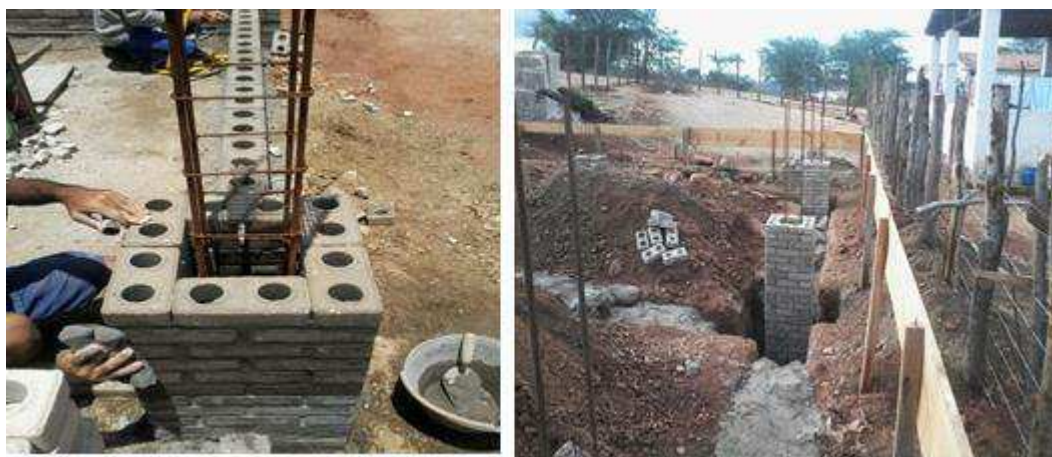
Figura 13 - Tijolo solo-cimento funcionando como forma de Pilar de concreto armado
