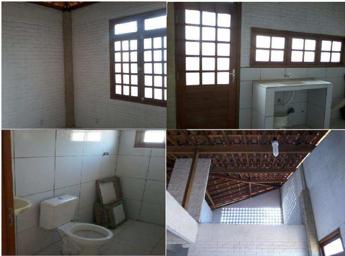
Figura 17- Fotografia de ambientes internos da casa. (a) Quarto com laje; (b) Cozinha; (c) Banheiro; (d) acesso ao Mezanino
