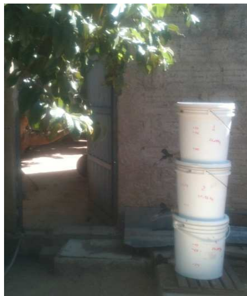
Figura 25 - Filtros instalados em residência.
