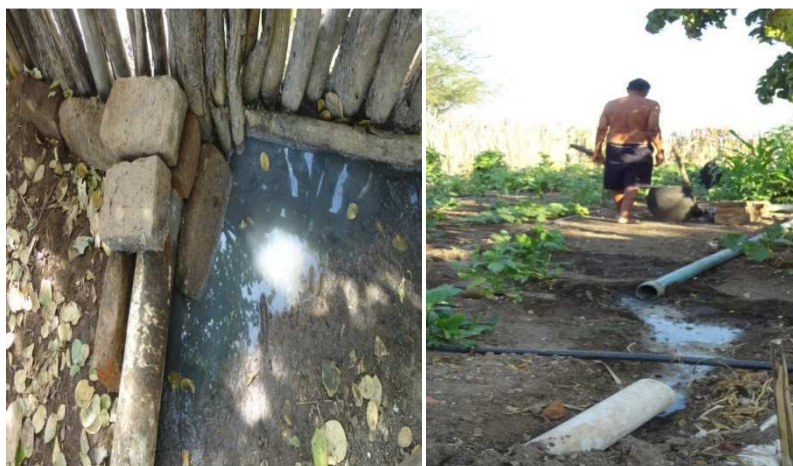
Figura 23 - Destino final de águas cinza para a irrigação.
