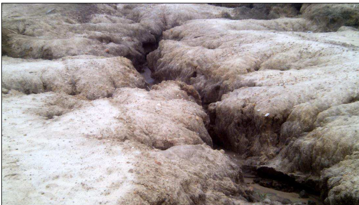
Figura 8: Solo com problemas de erosão
