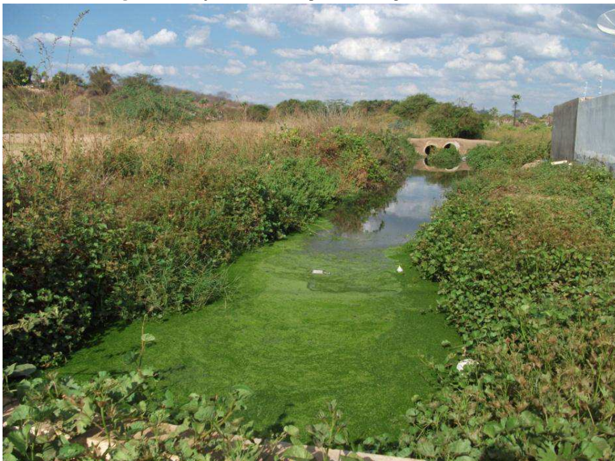
Figura 5 – Projeto Antônio Lopes Filho (esgoto a céu aberto)
