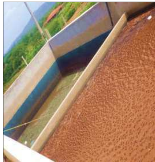
(b - Tanques de resfriamento)
