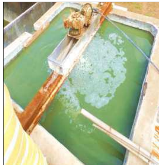
(d - Tanque de Floculação)
