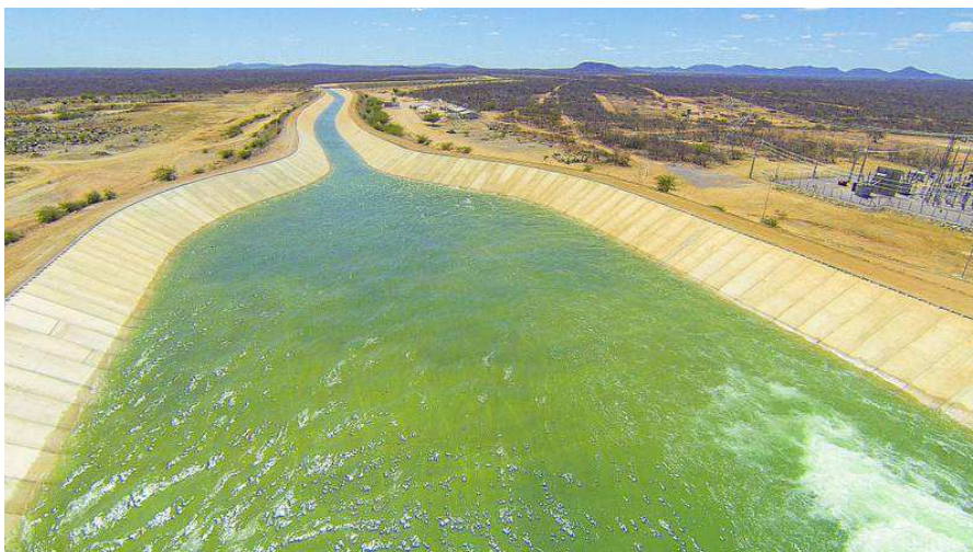
Figura 5 - Operação do canal do Projeto da Transposição do Rio São Francisco.
