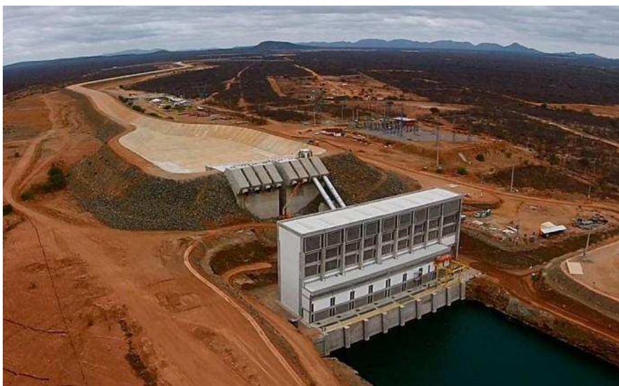
Figura 4 - Estação de bombeamento em Cabrobó (PE) - Ministério da Integração.
