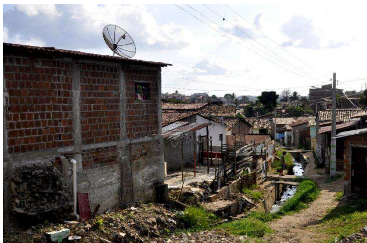
Foto 28 - Vista parcial do Canal do Pedregal. Foto Mariana Cavalcanti, 2015.
