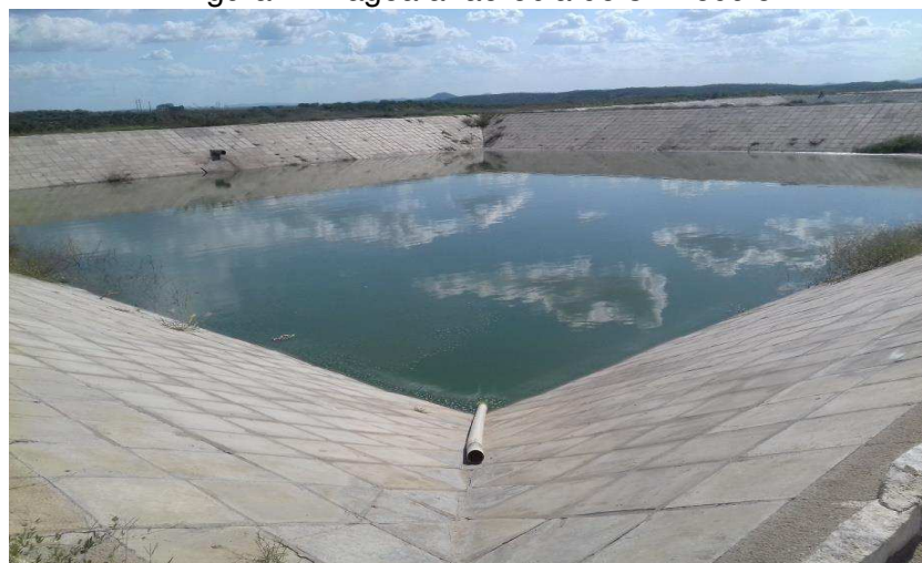
Figura 7 - Lagoa anaeróbica do 3º módulo
