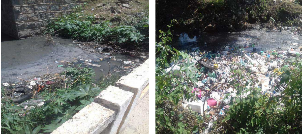
Figura 24 - Galerias de água pluvial em Pombal - PB
