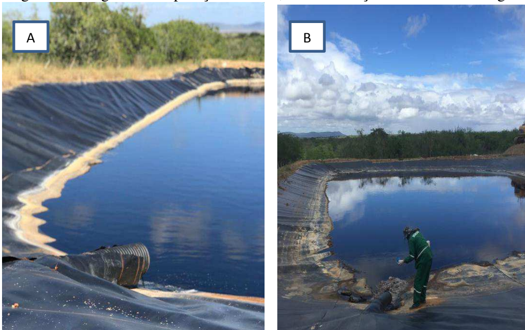
Figura 2-A Lagoa de Evaporação Natural; 2-B Tubulação de entrada da Lagoa
