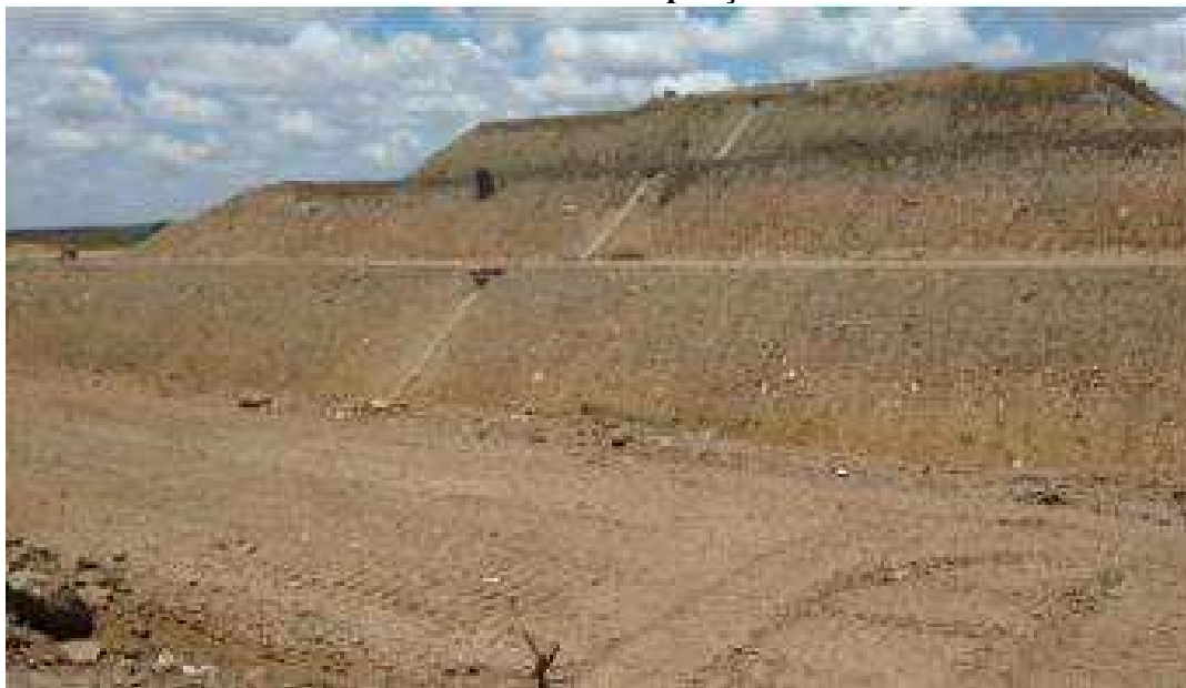
Figura 14 - Célula 2 do Aterro Sanitário em Campina Grande-PB, após encerramento das atividades de disposição
