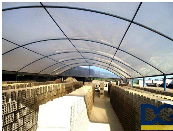
Figura 2.8: Galpão de secagem de tijolos cerâmicos. Fonte: DG, 2018.
