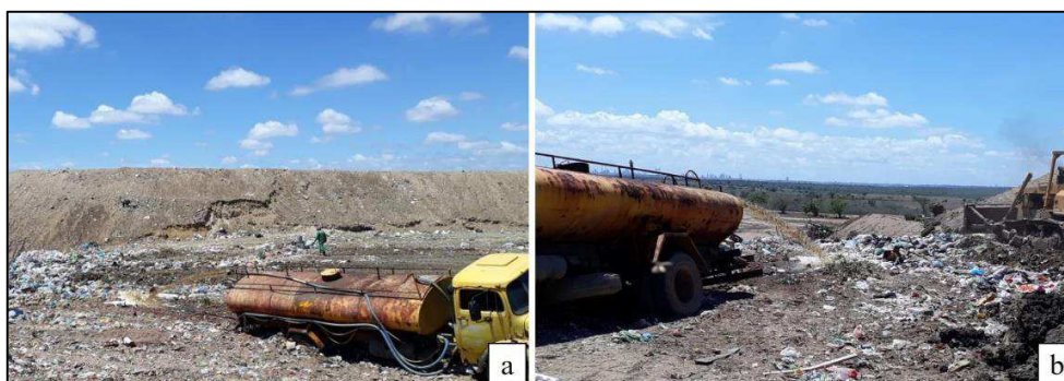
Figura 12. Lançamento de lixiviado nos RSU recém dispostos sobre a Célula
