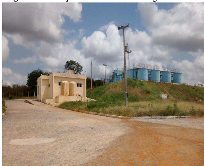
Figura 3.3. Estação de Tratamento de Água de Itatuba.
