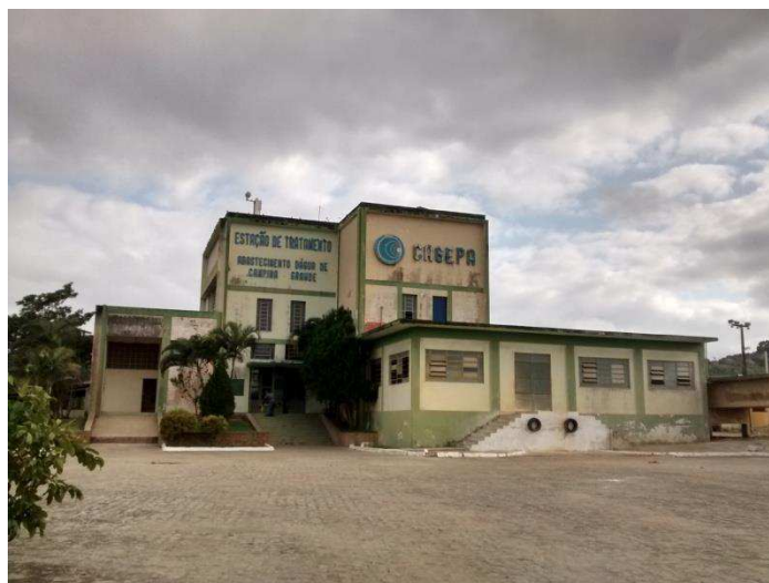
Figura 3.2. Estação de Tratamento de Água de Gravatá de Queimadas.
