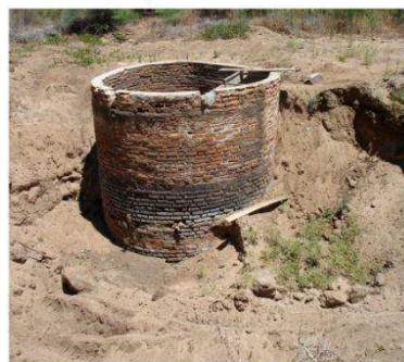
f) Poço P06
