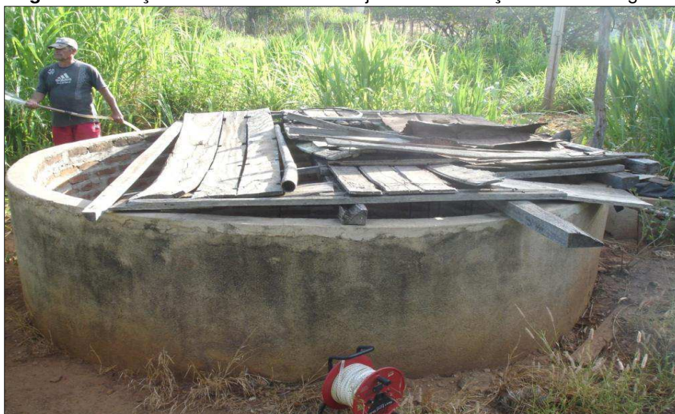
Figura 19 – Poço amazonas localizado a jusante dos lançamentos de esgoto.
