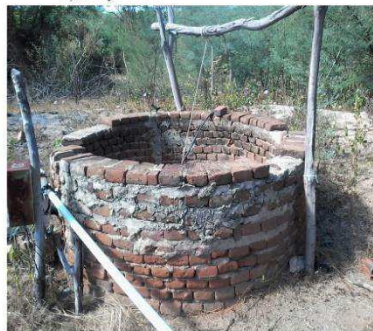
c) Poço P03
