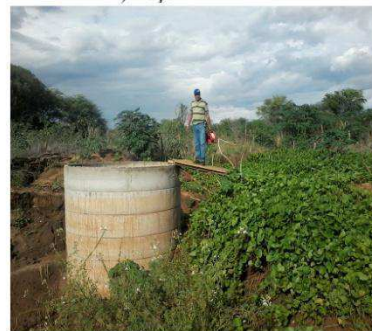
h) Poço P08
