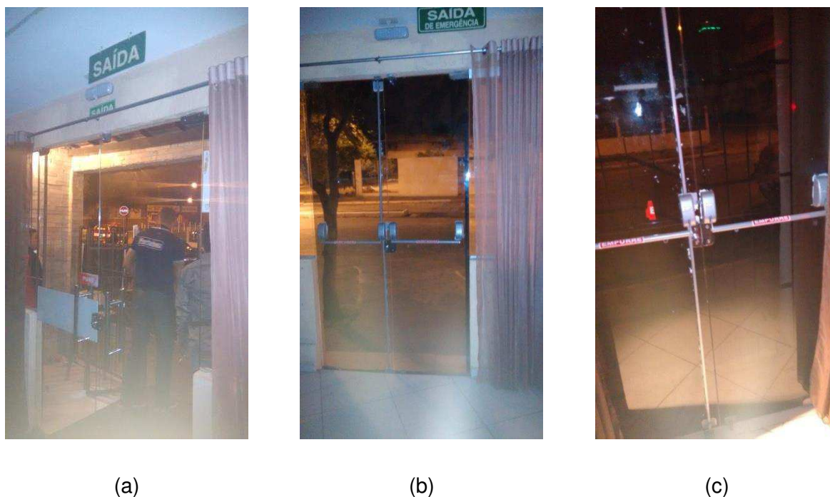
Figura 23: Portas da edificação B.
