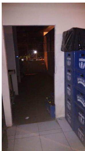
Figura 16: Fotos da vistoria da edificação A.
