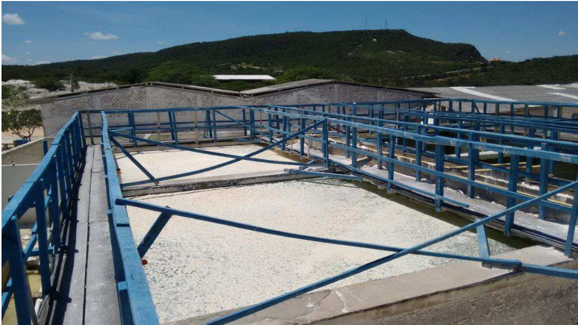
Figura 7: Tanques de decantação do caulim – Mineração São João Fonte: Autor, 2015.
