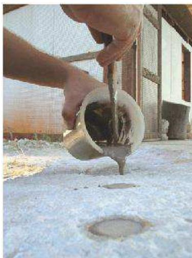
**Figura 5 - Operação de carregamento dos furos com a argamassa expansiva
