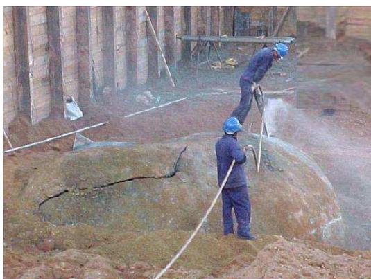
**Figura 6 - Execução de furos na rocha com martetele hidráulico (Fonte: ARAUJO NETO, 2006).**
